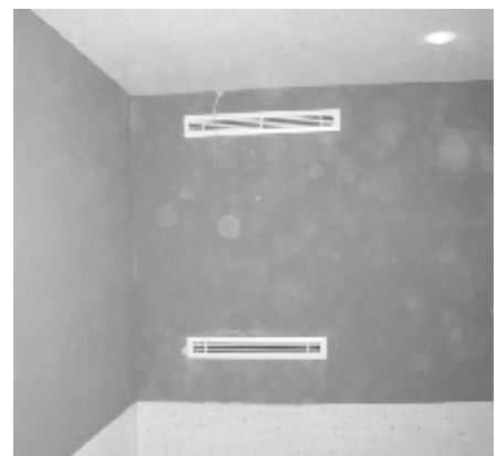
Вид из зала с бассейном перед очисткой отверстий
